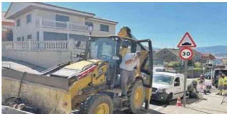
Operarios arreglando la fuga en la calle Tomás Mirambell.
